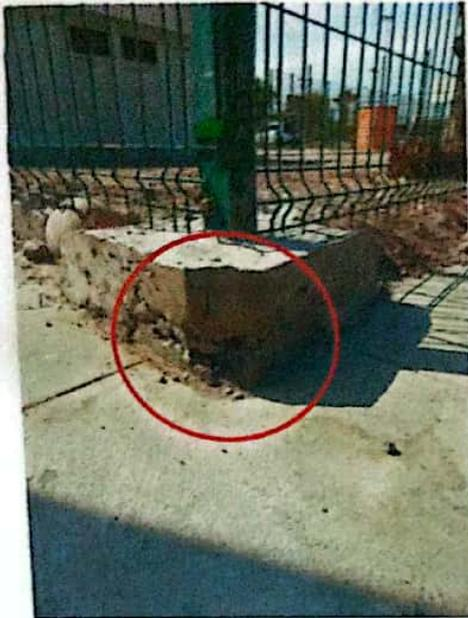
En este poyo se observan "nidos" producto de no utilizar vibrador para el encajado del concreto.
