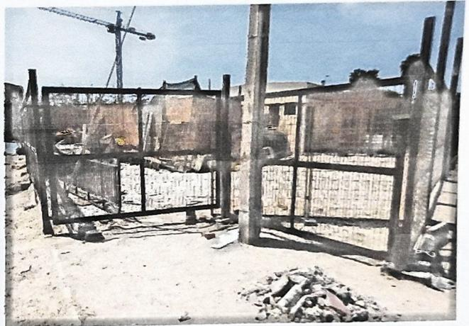
Pilares en perfil cuadrado de 50 x 50 x 2mm y 40 x 40 x 2 mm angulo doblado y plegado, accionado con malla de acma cerco galvanizado.
