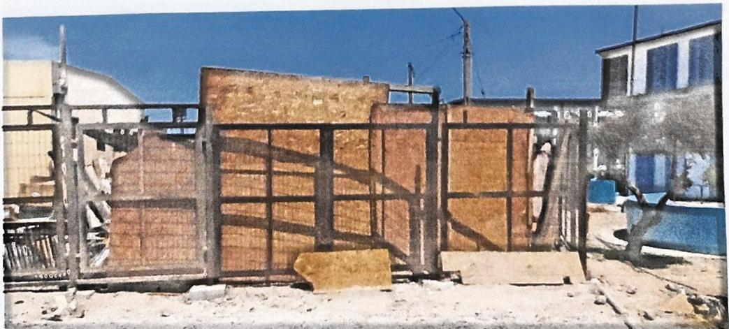
Instalación de paños de reja metálica instaladas en parte posterior.
