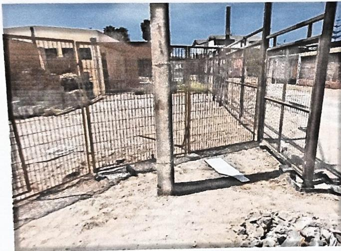
En el avance de los trabajos se instaló un nuevo paño de cierre de protección, se ejecutó con perfil metálico y malla tipo acma, empotrado con cimiento de hormigón armado.
