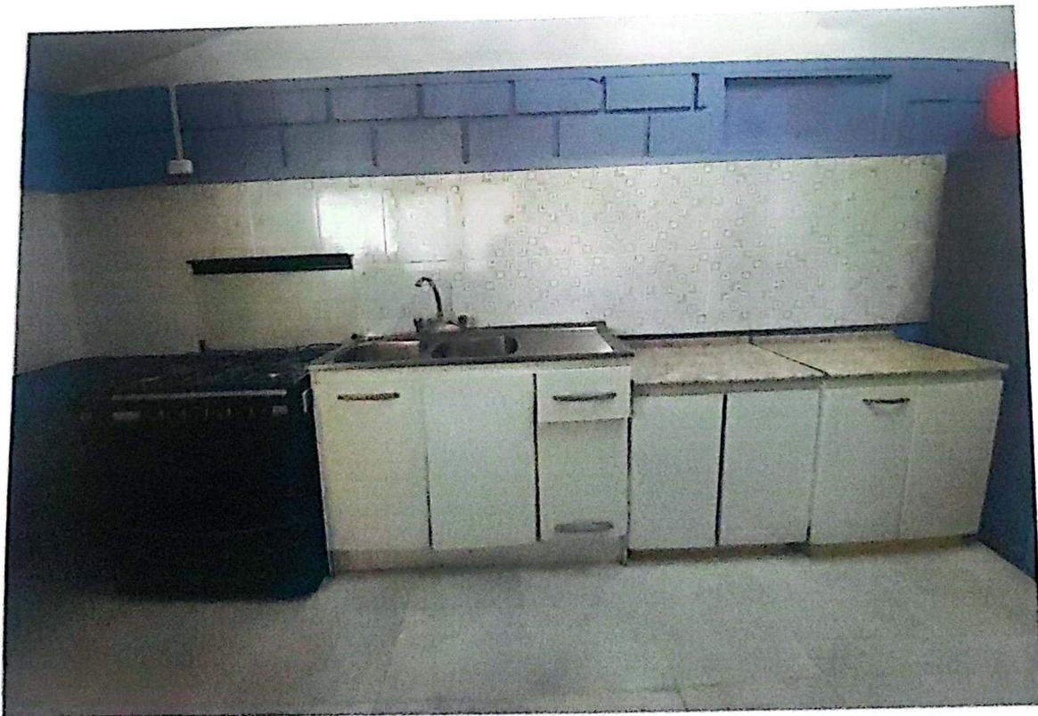
ESPACIO DESTINADO A COCINA, YA CONCLUIDO. REVESTIMIENTO CERAMICO EN PISO Y PARTE DE MURO, MEJORAMIENTO DE TECHUMBRE CERCHAS Y PLANCHAS ONDULADAS, CIELO INTERIOR DE PLANCHAS LISAS Y PINTADAS, PINTADO DE MURO DE BLOQUES DE HORMIGON A LA VISTA COLOR AZUL PIEDRA, ARREGLOS DE SISTEMA DE ILUMINACION ENCHUFES E INTERRUPTORES. TODO SE HA EJECUTADO COMO SE SEÑALA EN LAS ESPECIFICACIONES TECNICAS POR EL CONTRATISTA.
