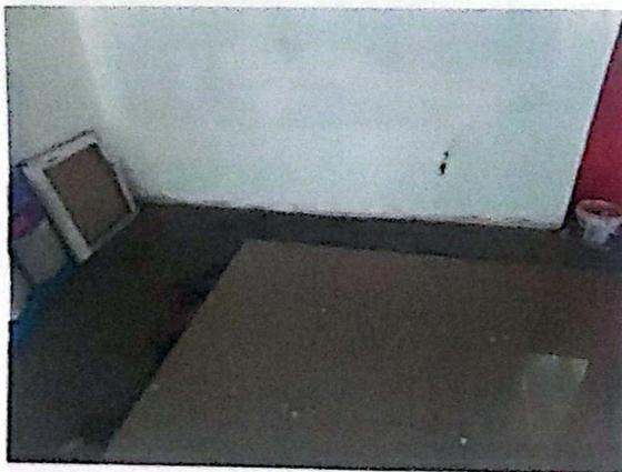
Se comienza con la aplicación de fragüe mezcla que cubre los surcos entre palmetas y separaciones, aplicación con espátula y esponja húmeda, dándole tiempo de secado de un día. En ciertos sectores debe cortarse parte de las palmetas para cubrir el área con disco de corte y esmeril angular para evitar imperfección de ella.
