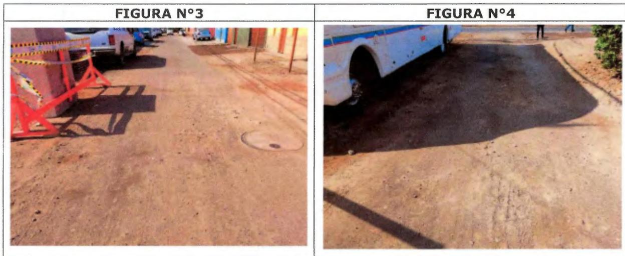
**Fotografías N°3 y N°4:** Deterioros predominantes sobre pavimento existente, grandes grietas y fisuras, hoyos, desprendimiento de la carpeta entre otros. **Pasaje Baldomero Lillo (Codpa-Tucapel).**
