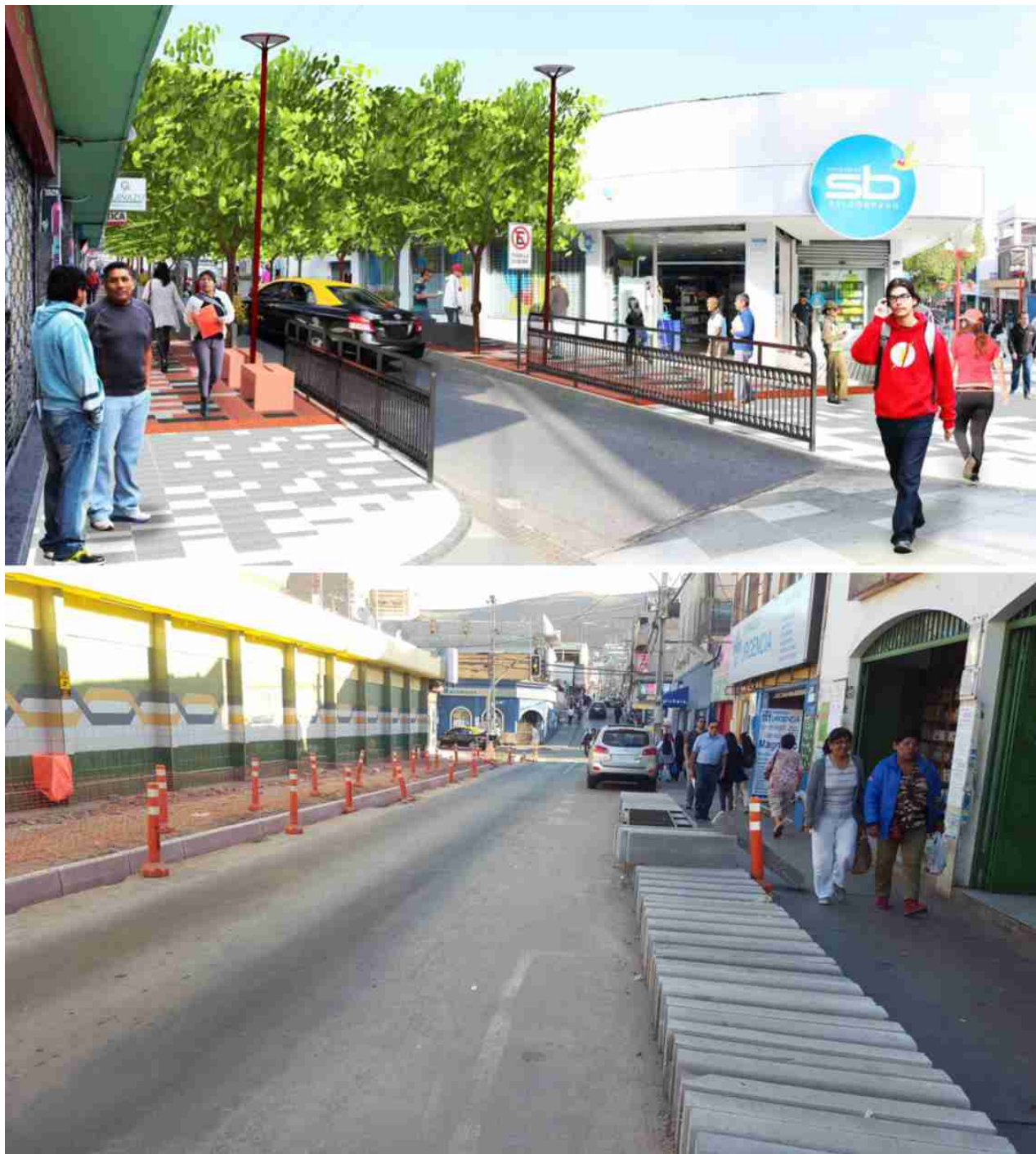
Imagen 11.1: Ejecución de proyecto reposición de veredas casco antiguo
