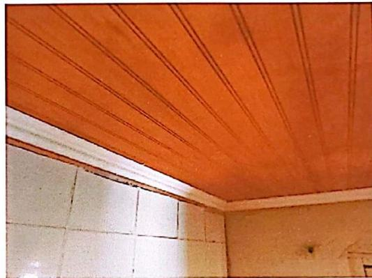
En interior de cocina, se mejoró en su totalidad el cielo, producto del deterioro por humedad y apollamiento, se instaló planchas de madera ranurada y barnizada, quedando en muy buenas condiciones.
