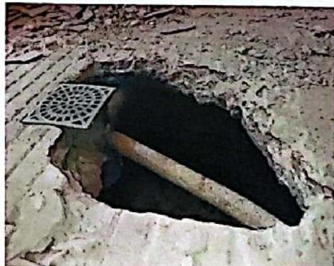
El pavimento de hormigón armado sufrió la quebradura de esta por el recambio de baldosas existentes, alrededor de unos 35 cm de diámetro en promedio aproximadamente.
