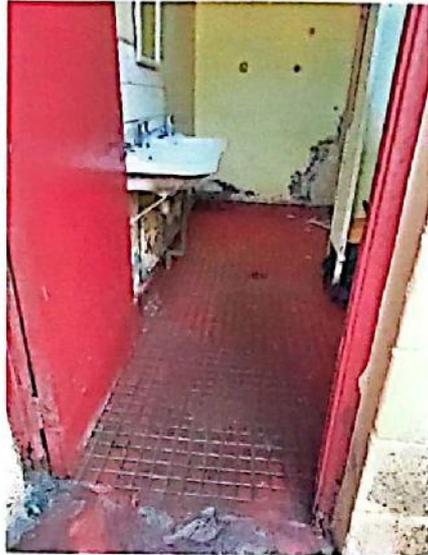
En Baño 2 piso baldosa, lavamanos con soporte metálico y muros con humedad.
