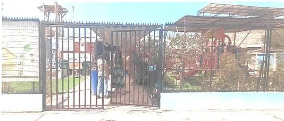
Acceso principal a sede por calle El Pedregal, se renovó la puerta-reja doble realizada en perfil metálico recubierta con antioxidante y pintura al óleo de color negro, como también la instalación de puntas de seguridad simple sobre esta.
