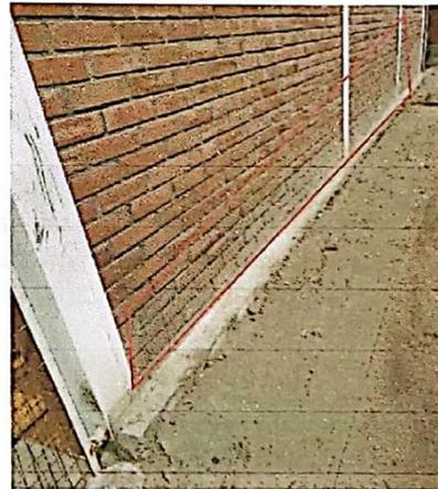
Muro exterior por costado oriente, su estructura de albañilería de ladrillos sufrió afloramiento de salinidad por humedad, hoy su aspecto se comporta de manera normal tras recibir tratamiento impermeabilizador.
