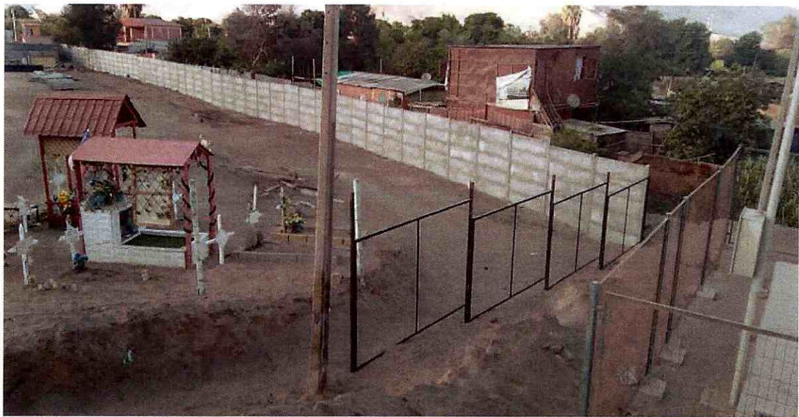
CIERRE PERIMETRAL, SISTEMA BULLDOG, PILARES Y PLACAS DE HORMIGÓN.
