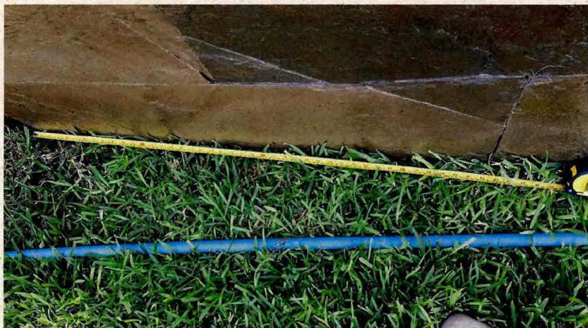
N° 18, piedra laja de 107 cms. en quincho unifamiliar N° 36
