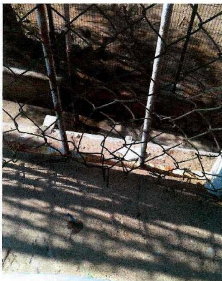
Fotografía 9- Malla bizcocho sin retorno en sector inferior en sector oriente.
