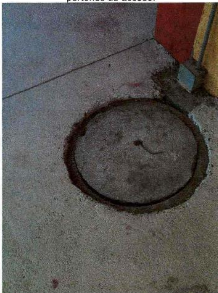
Fotografía 4- Tapa de cámara bajo el nivel del radier en acceso a baños sector sur.
