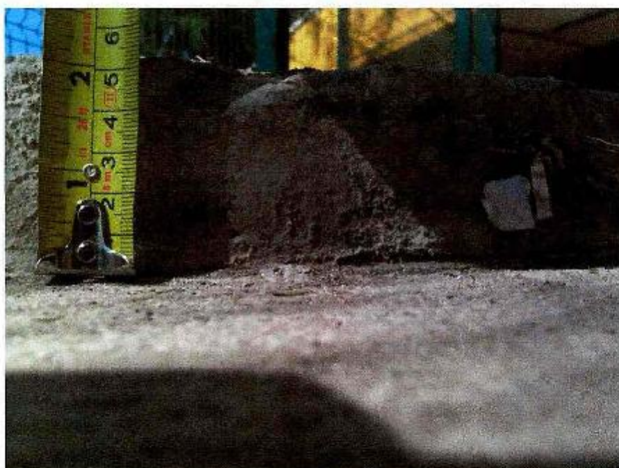
Fotografía 6- Diferencia tapa de cámara sobre el nivel del radier en acceso nororiente.
