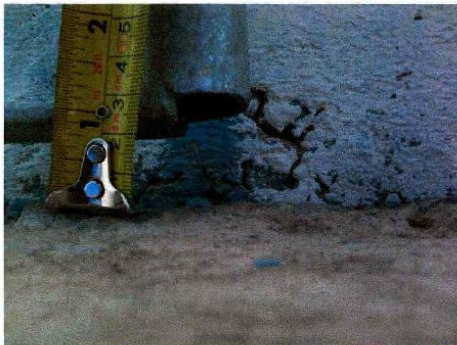
Fotografía 13- Diferencia entre el anclaje y la losa
