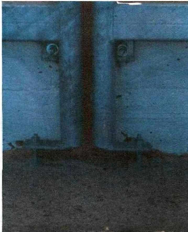
Fotografía 12- Anclaje a huella de butacas no fijada a losa en graderías sector norte.
