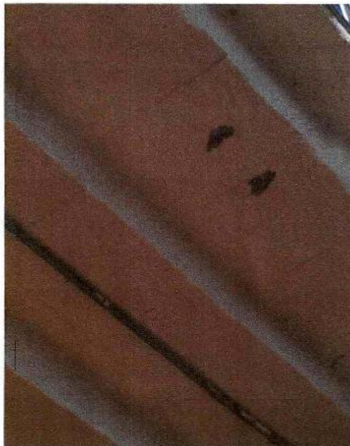
Fotografía 8- Pintura bajo las graderías descascarada en acceso norponiente
