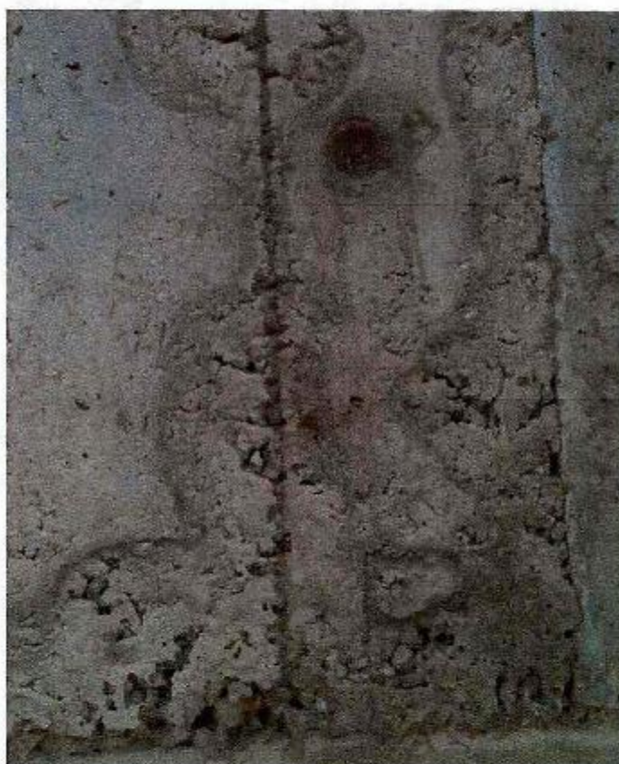
Fotografía 2- Nidos de piedra en muro de contención de rampa vehicular sector poniente.
