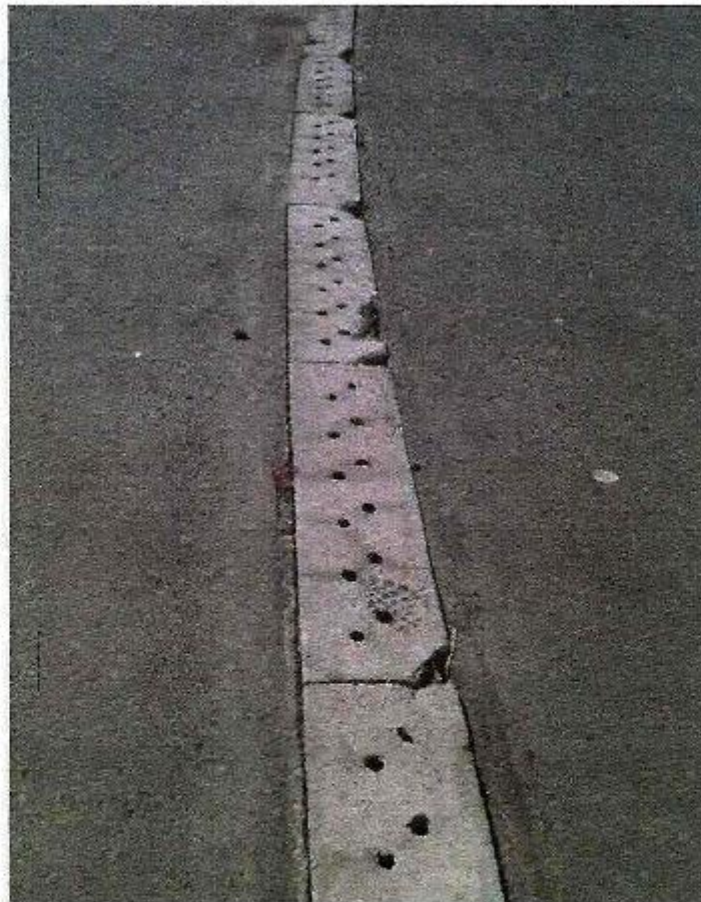
Fotografía 6- Canaleta y tapas de drenaje quebradas
