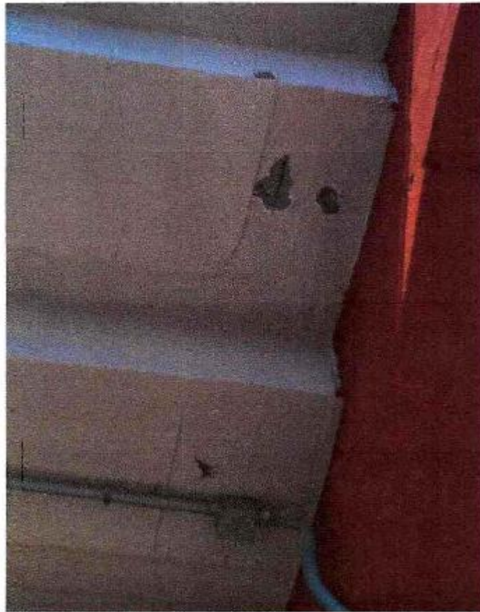
Fotografía 7- Pintura bajo las graderías descascarada en acceso norponiente.
