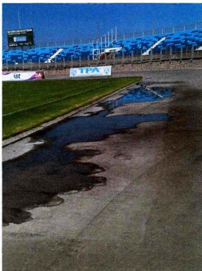
Fotografía 3- Apozamiento de agua por riego automatizado cancha
