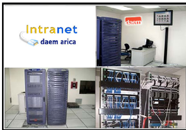
Instalación de los servidores de seguridad, telefonía IP y backup
