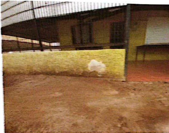
Muro medio antes.
