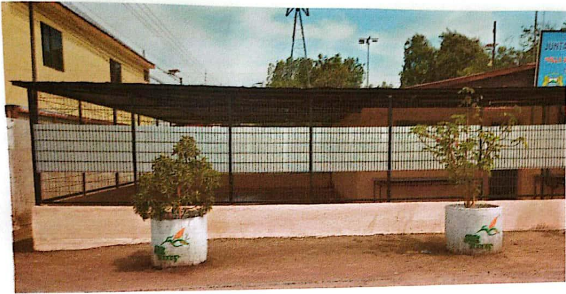
FACHADA PRINCIPAL, MURO MEDIO REJA Y FACHADA TERMINADA.
