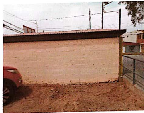
MUROS COSTADO CON COLUMNA PROTECCION.
