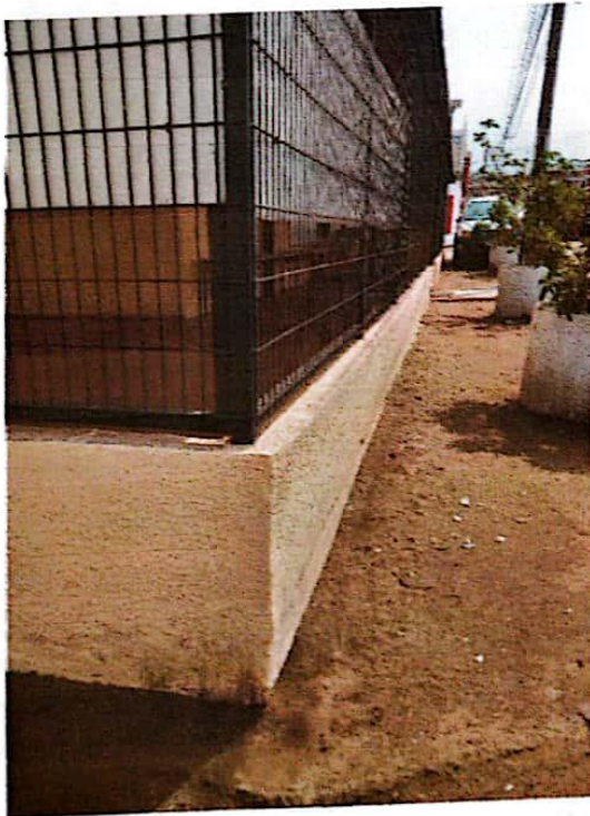
VISTA DESDE EL EXTERIOR MURO MEDIO REPARADO, REJA PROTECCION RECIBIÓ TRATAMIENTO ANTIOXIDO Y REPINTADO. MURO LATERAL SE AGREGÓ COLUMNA DE BLOQUES DE HORMIGON ARMADO PARA ELEVAR Y PROTEGER MURO EXISTENTE., LO CUAL TABIEN RECIBIÓ TRATAMIENTO DE PINTADO.
