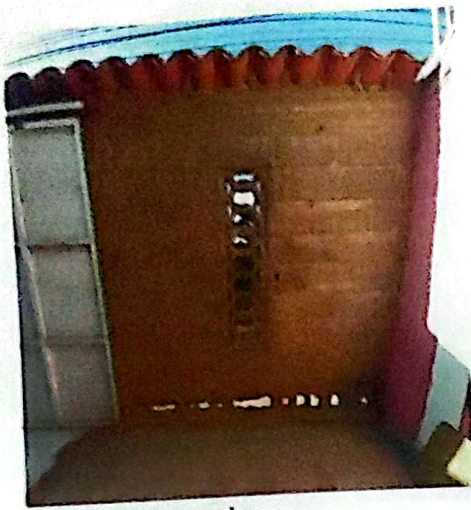
Muro interior antes.
