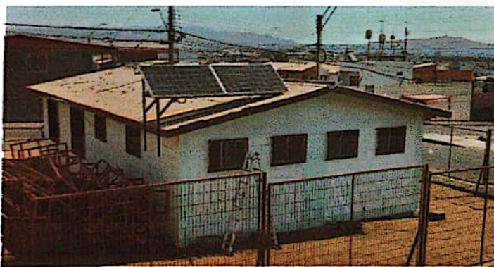
VISTA SEDE CON PANELES INSTALADOS
