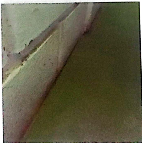
SURCOS ENTRE PALMETAS Y MUROS, SIN CONTENIDO DE FRAGUE SELLADOR.
