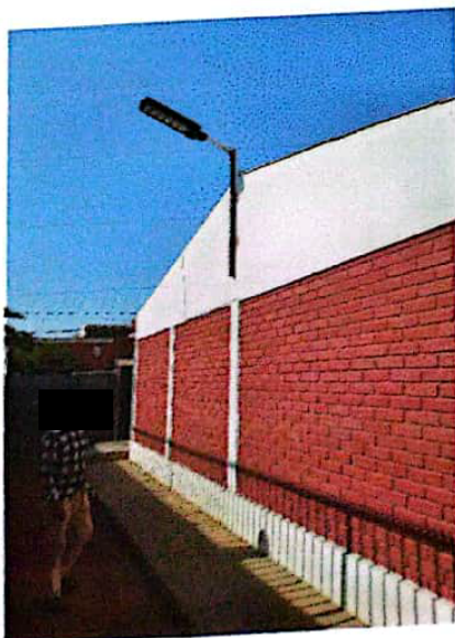
Se instalaron como parte del proyecto, 4 focos led de iluminación externa, con base en un tubo de perfil metálico en 4 puntos de ubicación.
