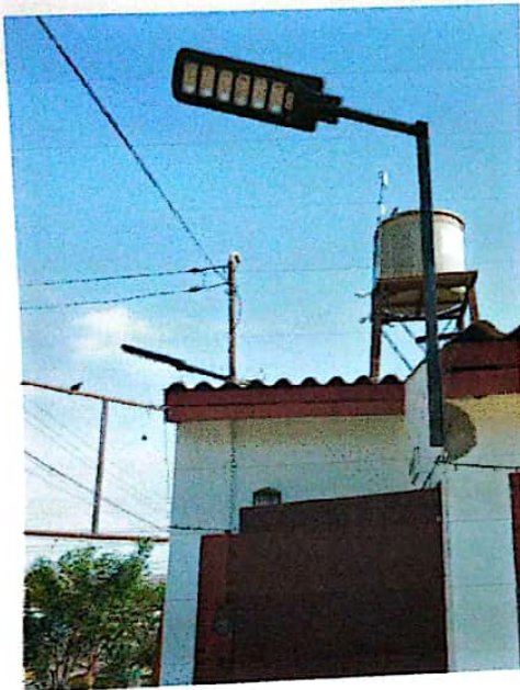
Se instalaron como parte del proyecto, 4 focos led de iluminación externa, con base en un tubo de perfil metálico en 4 puntos de ubicación.
