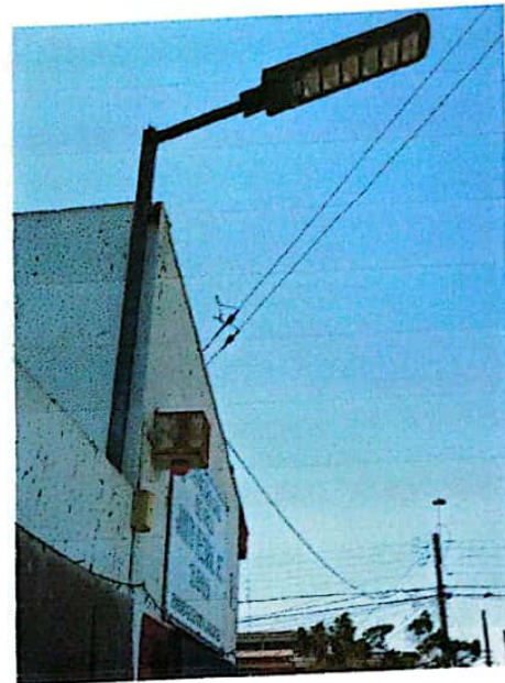
Se instalaron como parte del proyecto, 4 focos led de iluminación externa, con base en un tubo de perfil metálico en 4 puntos de ubicación.
