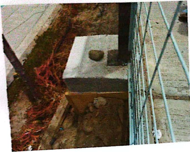
Poyos de concreto pilar en perfil metalico de 75 x 75 Capa de antioxidante y pintura posteriormente.
