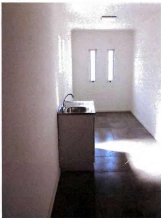
Antes de la instalación de cerámica.
