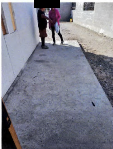
Pasillo acceso radier afinado cemento
