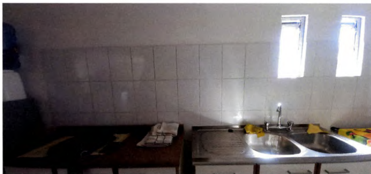
Revestimiento de cerámica instalado en muro.
