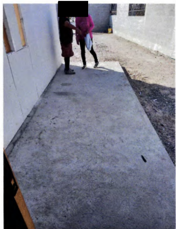
Radier afinado cemento en pasillo acceso
