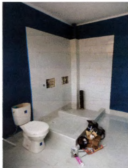
VISTA ACCESO PRINCIPAL, SE NIVELO PISO CON RECUBRIMIENTO DE CERAMICA, SE INSTALÓ 2 RECEPTACULOS DE DUCHAS CON CERAMICA A MURO, PINTADO DE MUROS Y 2 LAVAMANOS.
