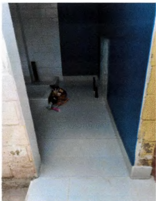
VISTA ACCESO PRINCIPAL, SE NIVELO PISO CON RECUBRIMIENTO DE CERAMICA, SE INSTALÓ 2 RECEPTACULOS DE DUCHAS CON CERAMICA A MURO, PINTADO DE MUROS Y 2 LAVAMANOS.
