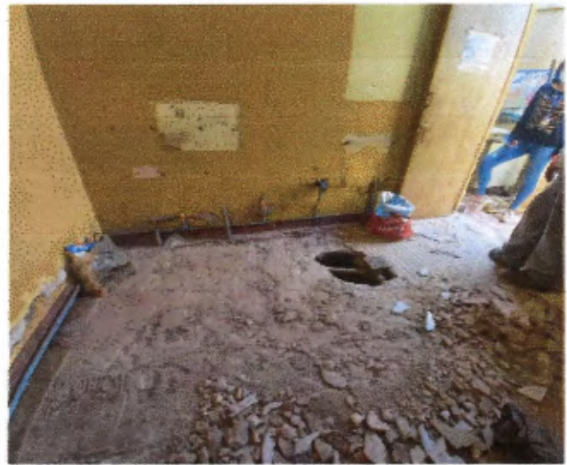
Vista general piso con deterioro de piso por socavón.
