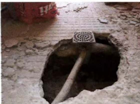
Una vez en rotura de radier se observa el sistema de tuberías de PVC interno que se encuentran suspendidas por la cámara de registro.
