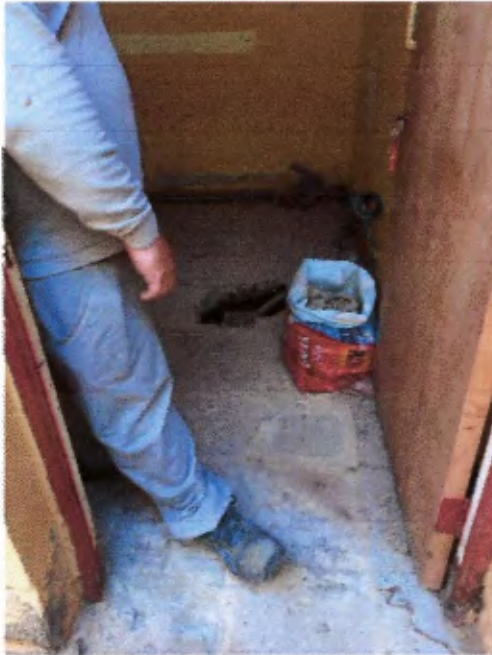
Vista general piso con deterioro de piso por socavón.
