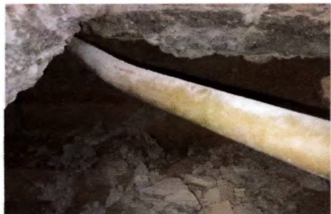
Una vez en rotura de radier se observa el sistema de tuberías de PVC interno que se encuentran suspendidas por la cámara de registro.
